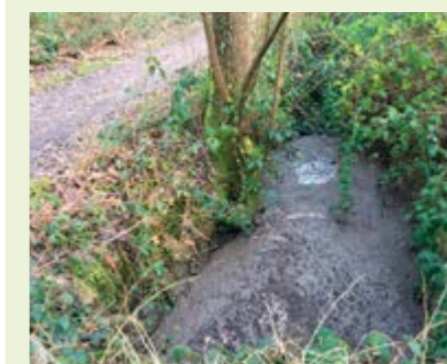
boues - station d'épuration en sortie buse béton forêt Port Royal 17.01.2017 - source : AAVRE
